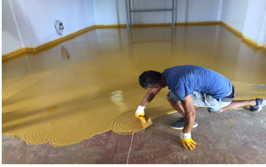
Poliurea Zemin Kaplama
